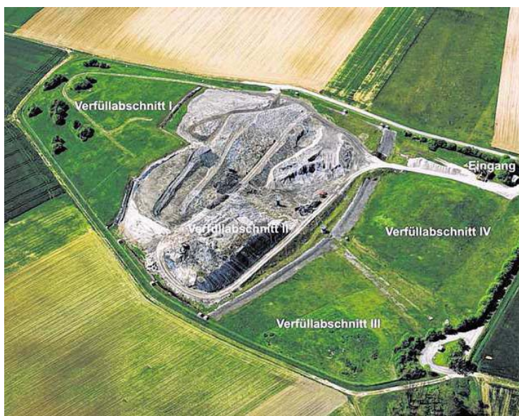
Eine kostbare Ressource: Die Deponie Hopperstadt aus der Luft.
