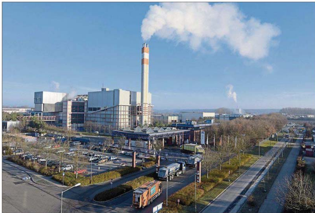
Abfallverwertungsanlage in Augsburg.
